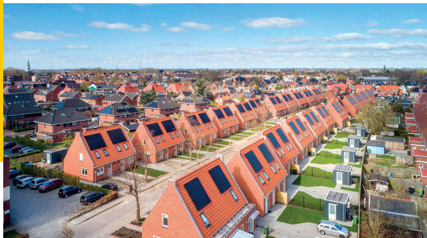
46 aardbevingsbestendige woningen in Appingedam (Fijn Wonen)
