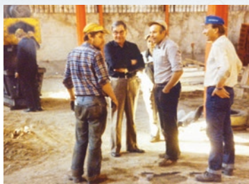
Kiikoisten tehdas rakennusvaiheessa
