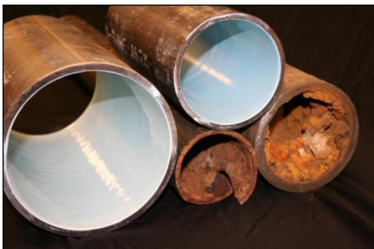
Bilde 7.2 – Groe i gamle rør versus nye (ubrukte) rør.
