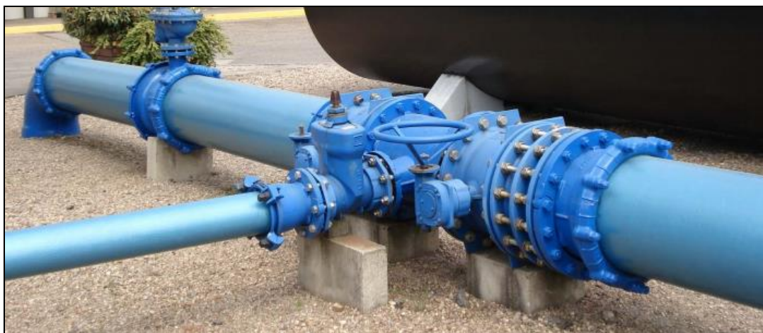
Bilde 4.1: Duktilt støpejernsrør med tilhørende armatur og flenser.
