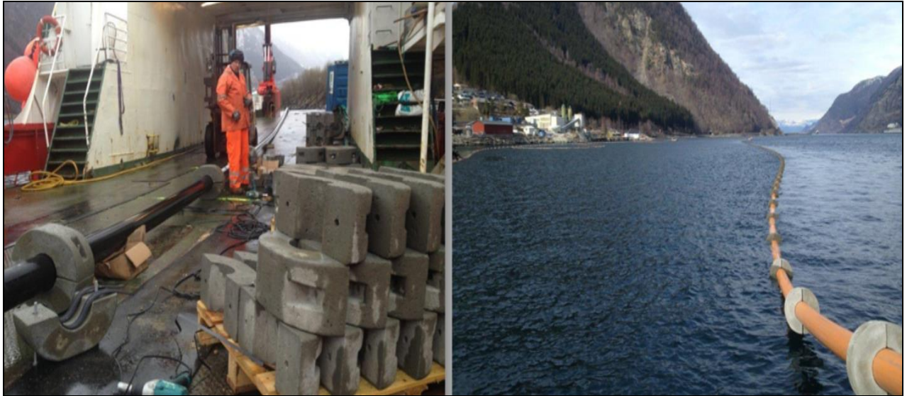
Bilde 4.3: Legging av PE rør med betongbelegg.
