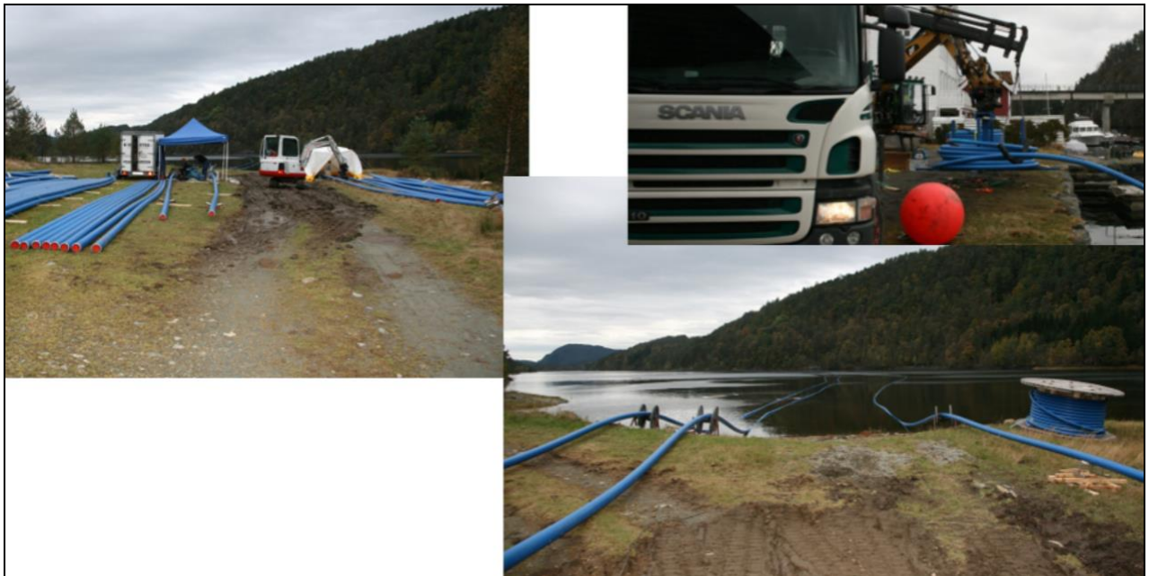
Bilde 4.4 Legging av vektet PE rør.
