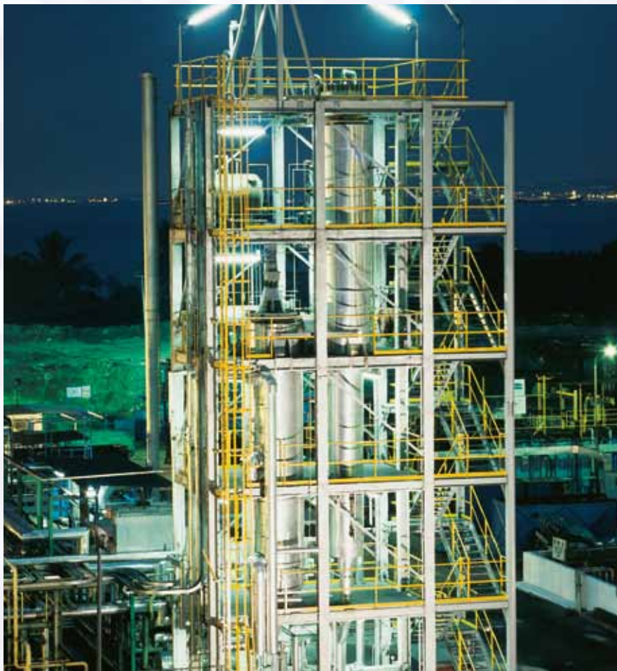
Planta de destilação óleo de lavagem (Singapura)
