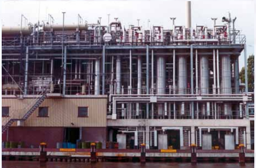
Planta de evaporação de múltiplas fases para destilação de micela
