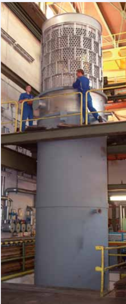
Evaporador de película fina em nossas instalações de teste
