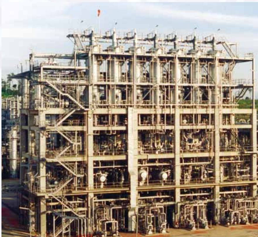
A maior planta de evaporação de trajeto curto de múltiplas fases no mundo para a produção de ceras macia e dura
